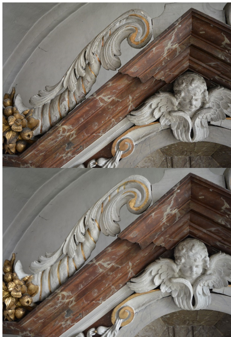
Detailopname van de bekroning links bovenaan het altaar voor (boven) en na (onder) de restauratie. Foto's: ChromArt
