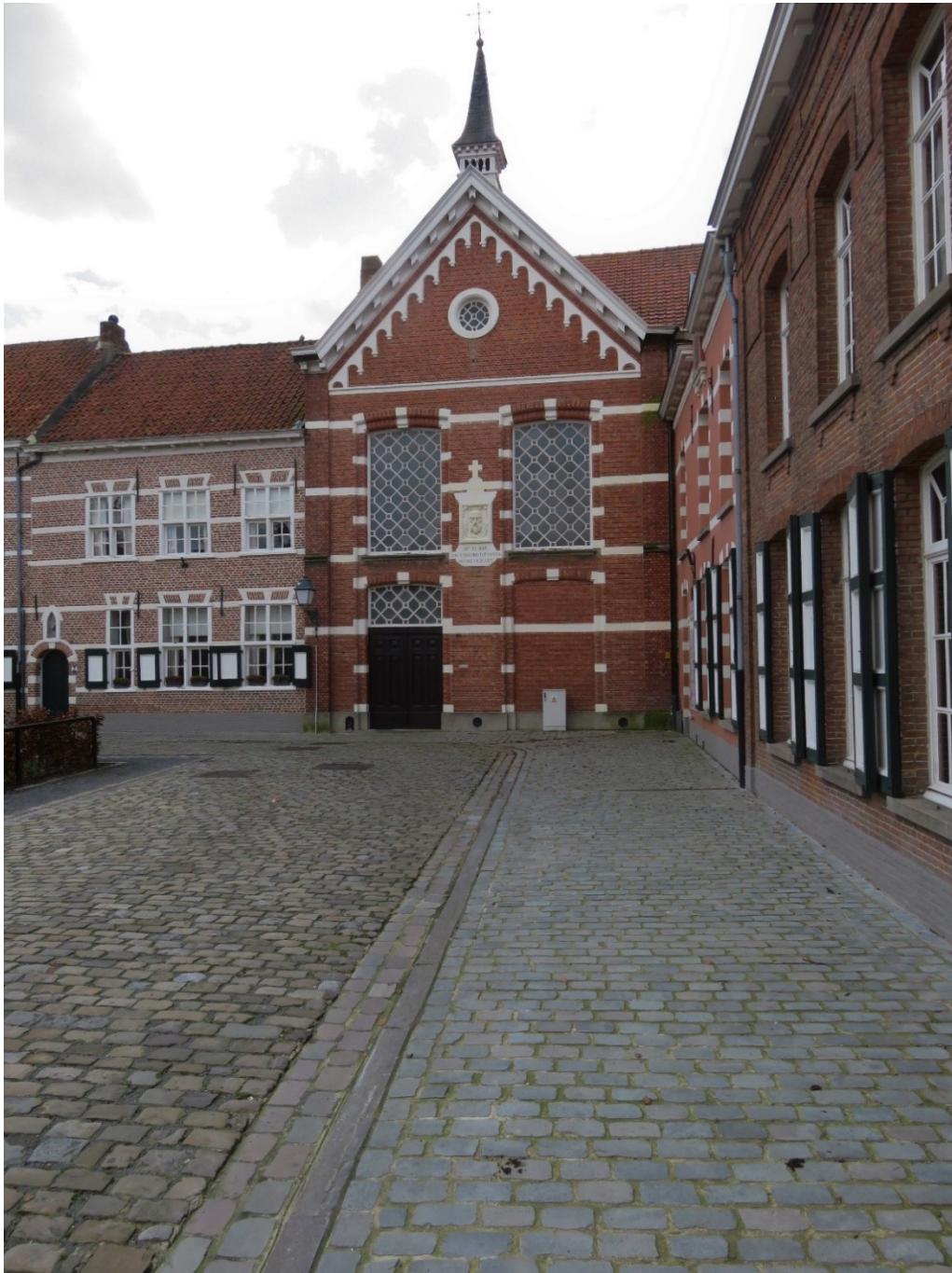
Foto 4: De neoclassicistische bakstenen kapel telt drie traveeën en twee bouwlagen, onder haaks in elkaar gewerkte pannen, zadeldaken met dakruiter op de nok. 12 Het klokje werd in januari 1884 door A.L.J. Van Aerschot en zoon in Leuven gegoten. 13 Aan de straatzijde is de kapel afgewerkt met een twee traveeën brede puntgevel op arduinen plint. De gevelversiering bestaat uit bepleisterde en beschilderde speklagen, hoek- en negblokken, bas-reliëf (Foto 5) en een driezijdig fronton met boogfries en oculus onder een houten kroonlijst. De 'voorgevel' is voorzien van vensters met een gebogen vorm aan de bovenkant en een deur met ruitvormige tracering. 12
