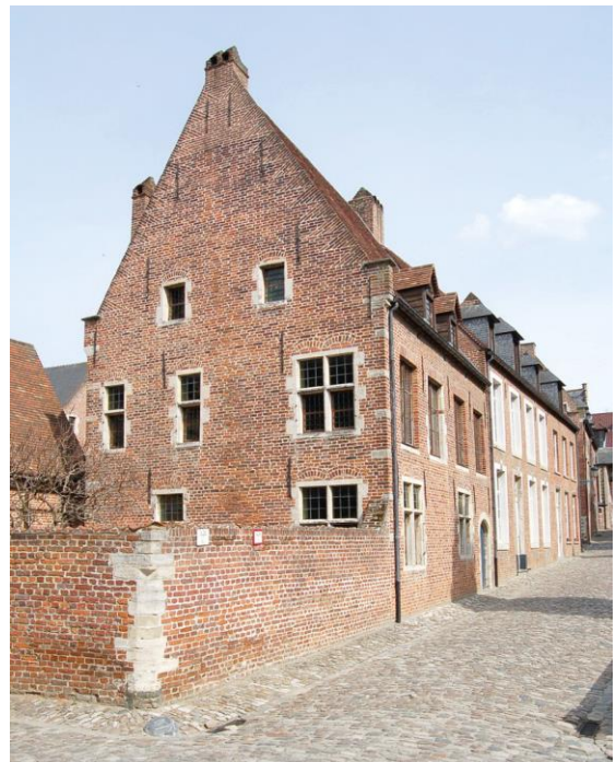
Alle gebouwen werden grondig gerenoveerd in de jaren '60 en '70 en worden nu bewoond door gastprofessoren, studenten en personeelsleden van de universiteit.
