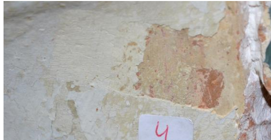
Aanduiding van de voegen Stratigrafisch venster, van rechts naar links: terracotta, Tussen de verschillende origineel, tweede interventie, derde interventie onderdelen
