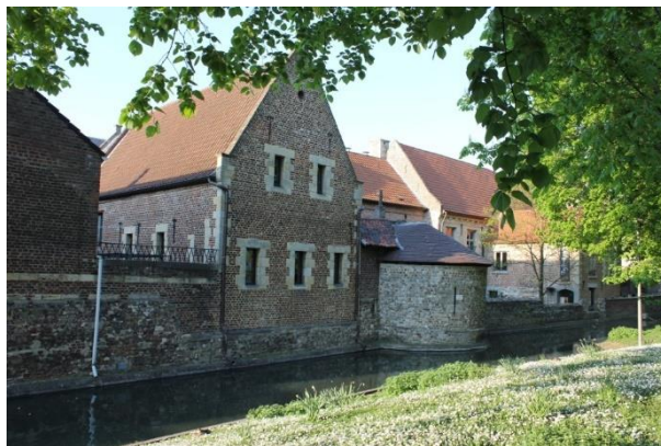
Zicht op de resten van de Lakenmakerstoren (13 de eeuw) en de achtergevel van het Brouwhuis (2de kwart van de 17de eeuw).
